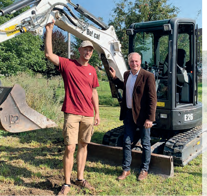
Luzian Reinhardt (li) hat in der Verlosung den Spatenstich mit dem Bagger gewonnen. Gossaus Gemeindepräsident, Jörg Kündig, gratuliert dem Cevi Gossau zum offiziellen Baustart. (Foto: Rita Förster)
