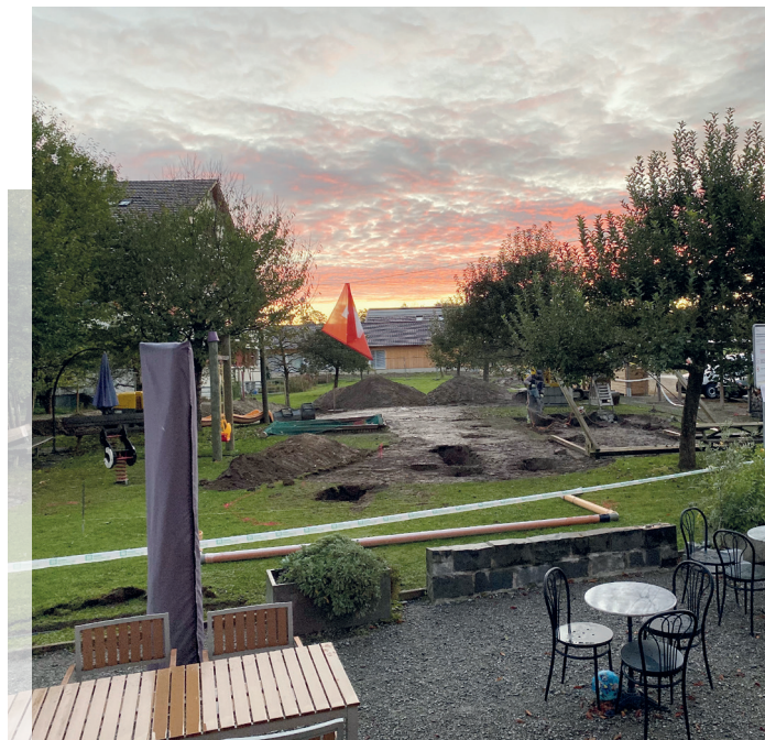
Die Bauarbeiten auf dem KGH-Spielplatz sind im Gange... (Foto: K. Lisser)
